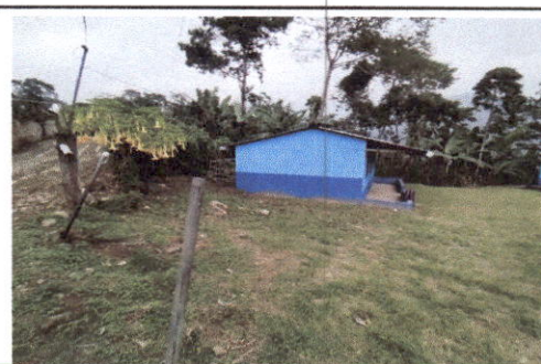
FOTO 4: Reparación de tubo hg y malla galvanizada
