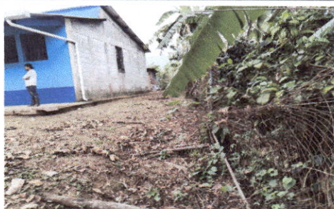
FOTO 5: Reparación de tubo hg y malla galvanizada
