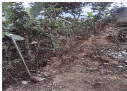
FOTO 2: Reparación de tubo hg y malla galvanizada
