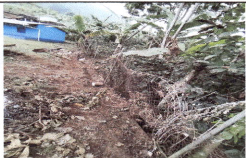
FOTO 1: Reparación de tubo hg y malla galvanizada
