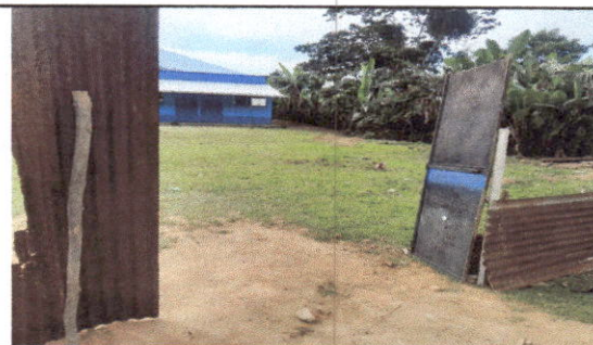
FOTO 6: Fabricación e instalación de portón de metal de ingreso
