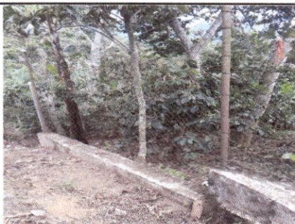
FOTO 3: Reparación de tubo hg y malla galvanizada
